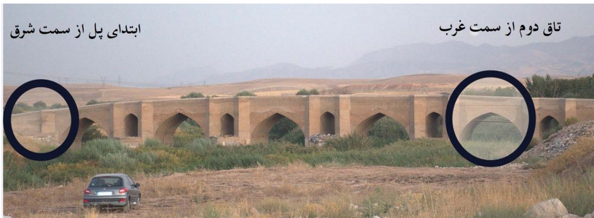
تصویر ۷: قسمت‌های تخریب‌شده در پل در جنگ جهانی اول - چشمه تاق دوم از سمت غرب و ابتدای پل از سمت شرق (نگارندگان، ۱۴۰۳). Fig. 7: Parts of the bridge destroyed in World War I - The second arch spring from the west and the beginning of the bridge from the east (Authors, 2024).
