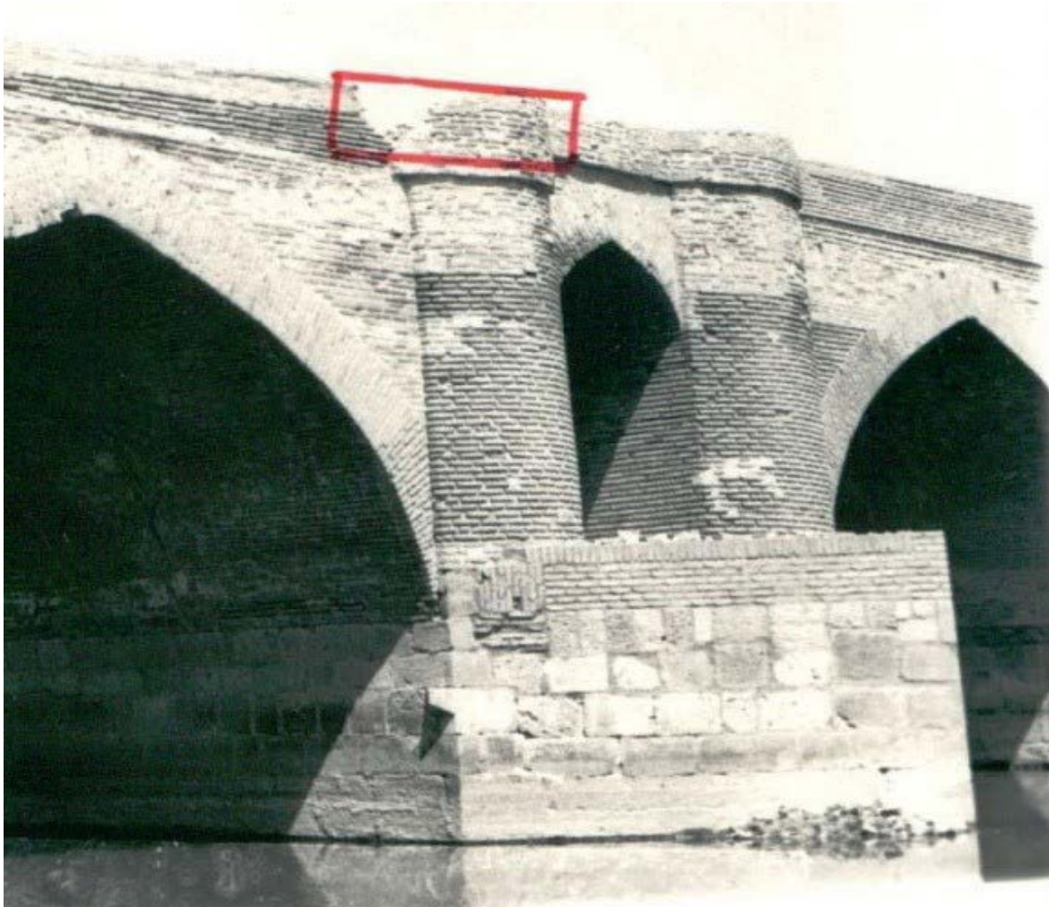
تصویر ۶: یکی از پایه‌های پل دید از جنوب سیل شکن و روکار آن‌ها با بلوک‌های سنگی مکعب مستطیل (مرکز اسناد میراث فرهنگی و گردشگری، ۱۳۶۱؛ https://lib.richt.ir/1361 ).
