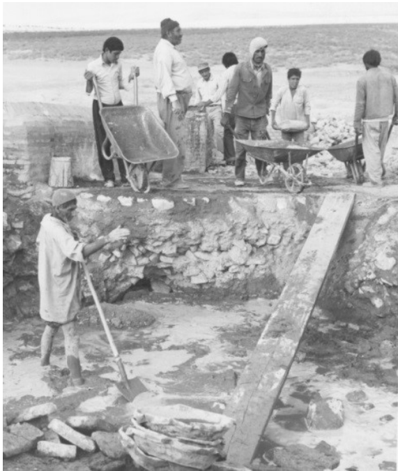
تصویر ۵: قسمت داخلی آن‌ها با ملات گچ و لاشه‌سنگ ساخته شده (مرکز اسناد میراث فرهنگی و گردشگری، ۱۳۵۴). https:// lib.richt. (ir/1354)
