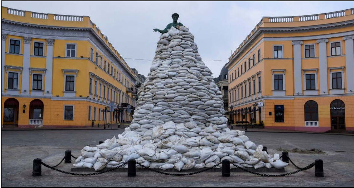
شکل ۴: استفاده از کیسه‌های شن برای حفاظت از اثر یادبود دوک دو ریشلیو، بنیان‌گذار شهر اودسا در اوکراین (الکساندروس آورامیدیس/رویترز). Fig. 4: Using sandbags to protect the memorial of Duke de Richelieu, the founder of the city of Odessa in Ukraine (Alexandros Avramidis/Reuters).
