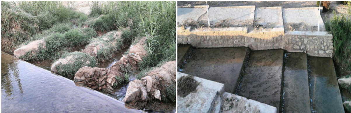
تصویر ۲. نحوه معماری و تقسیم‌بندی آب به وسیله پارا در شهر سمنان. (مأخذ: نگارندگان)
